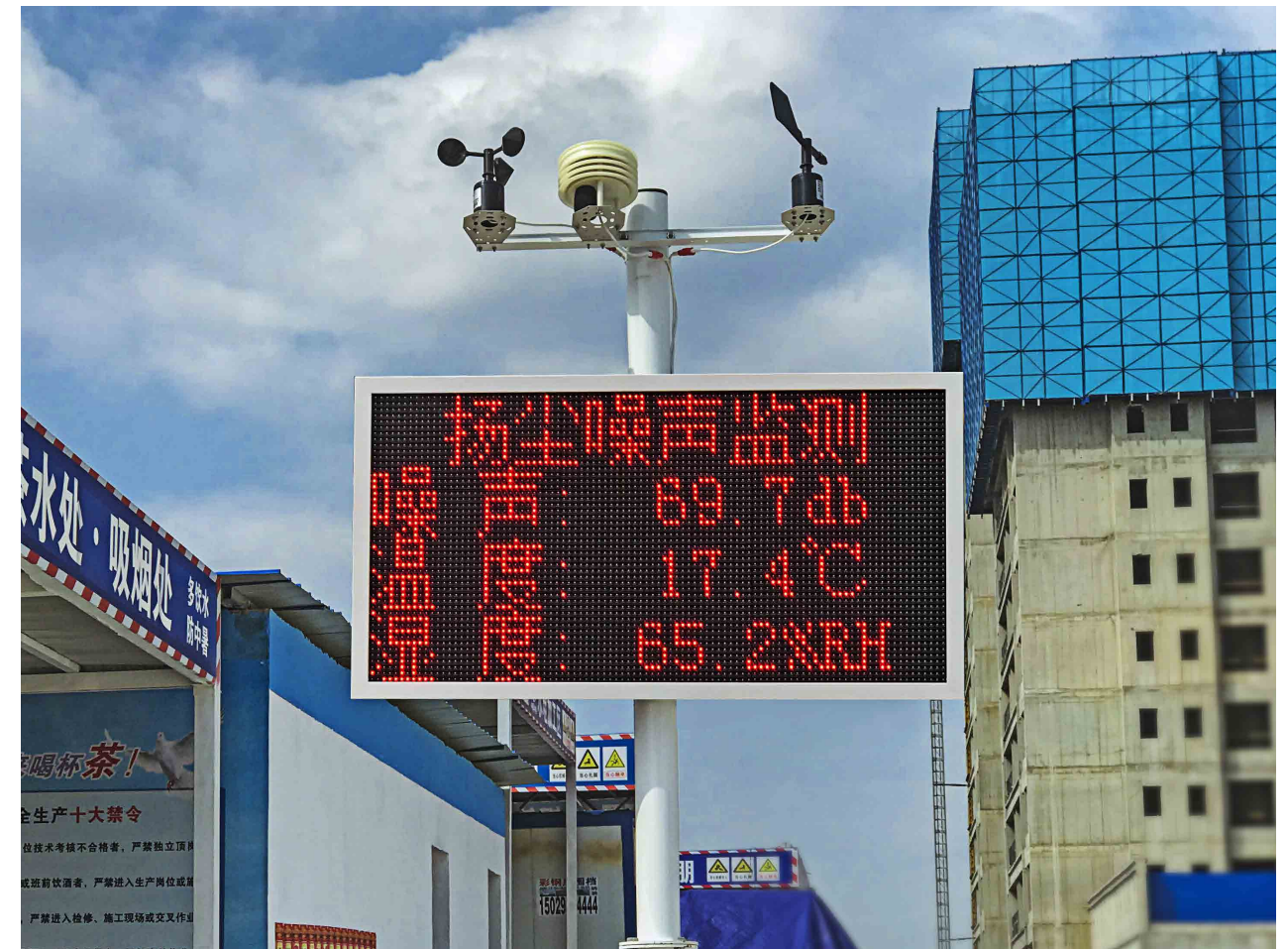
噪音实时监测设备
