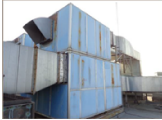
华润凤凰置地广场 A 座屋面热回收机改造项目
