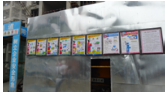
施工现场建筑调试房
