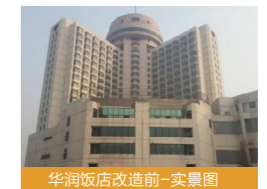
华润饭店改造前-实景图
