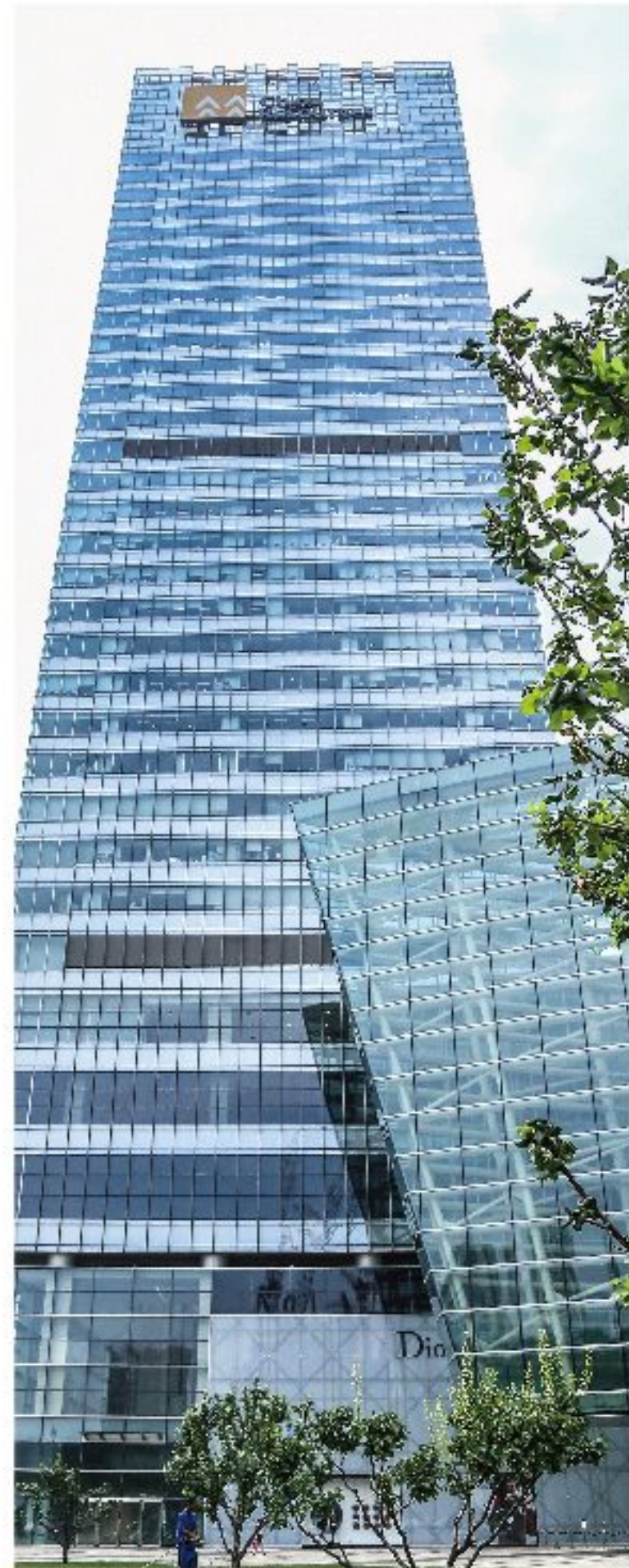
▲ 沈阳华润中心写字楼
