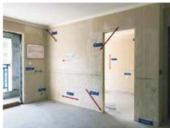
南昌紫云府石膏砂浆抹灰墙面
