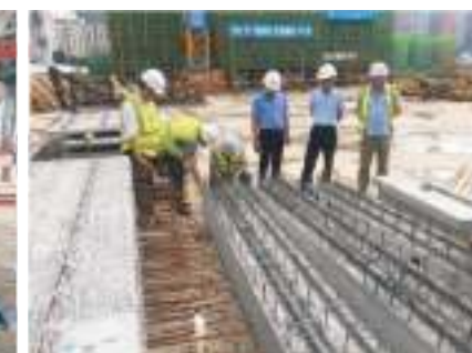
武汉琨瑜府一期预制构件进场验收
