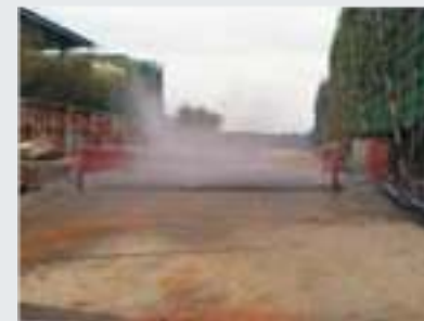
洗车槽和高压冲洗设备
