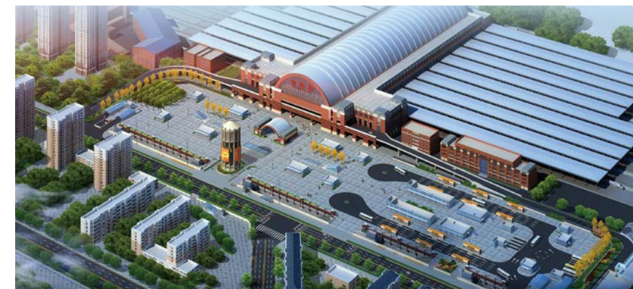
沈阳站西广场停车场
