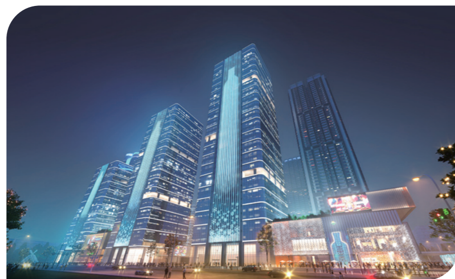
雪花科创城工业改造项目
