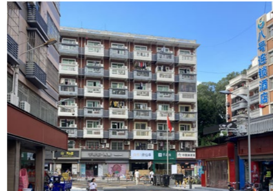
深圳南山白石洲村综合治理项目
