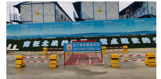
工地安装洗车槽
