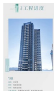
深圳大区公众号对深圳大区各项目月度发布工程进度进行真实播报
