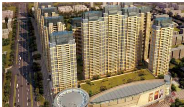
鞍山教育局項目 Anshan Education Bureau Project
